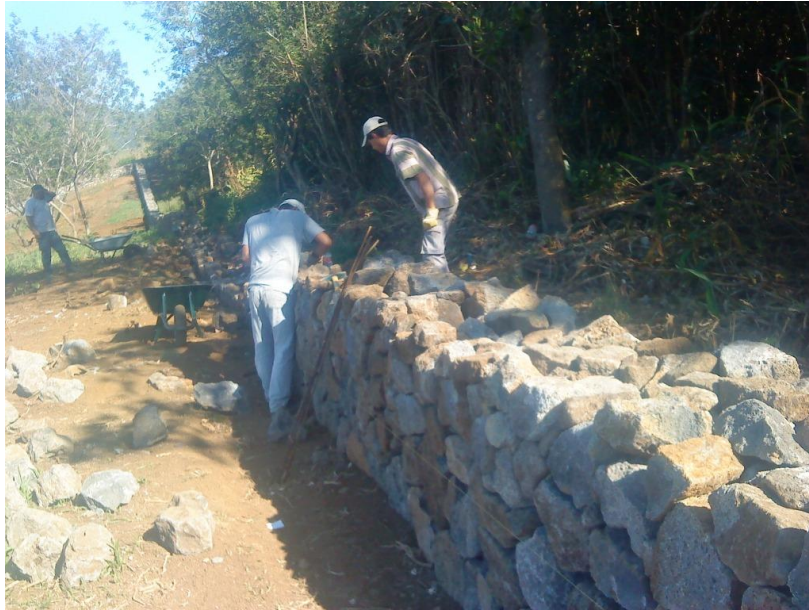
Figure 15 : Construction d'un enclos en pierres sèches sur le site de l'association les Fangourins, Source : Association APPER
