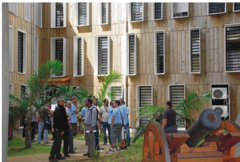
Figure 8 : Un exemple de bâtiment en bardage de Cryptomeria Japonica à La Réunion, Source : www.clicanoo.re , google image
