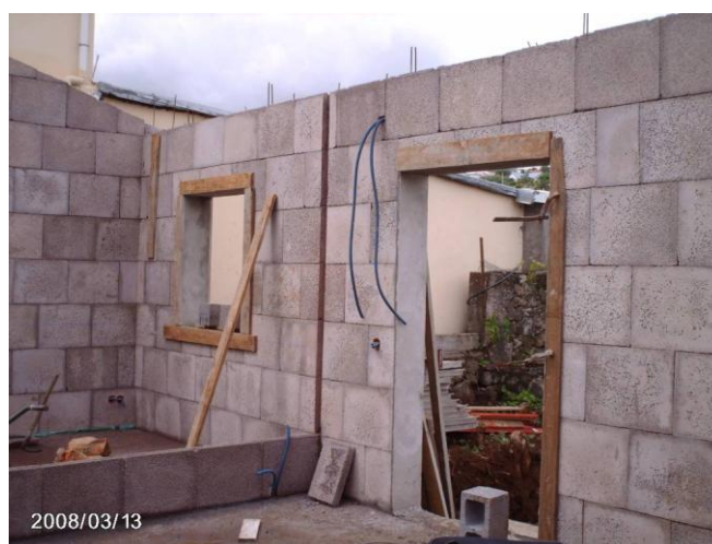
Figure 13. : Exemple d'une maison en parement Haclave, Source : Google image, parement Haclave
