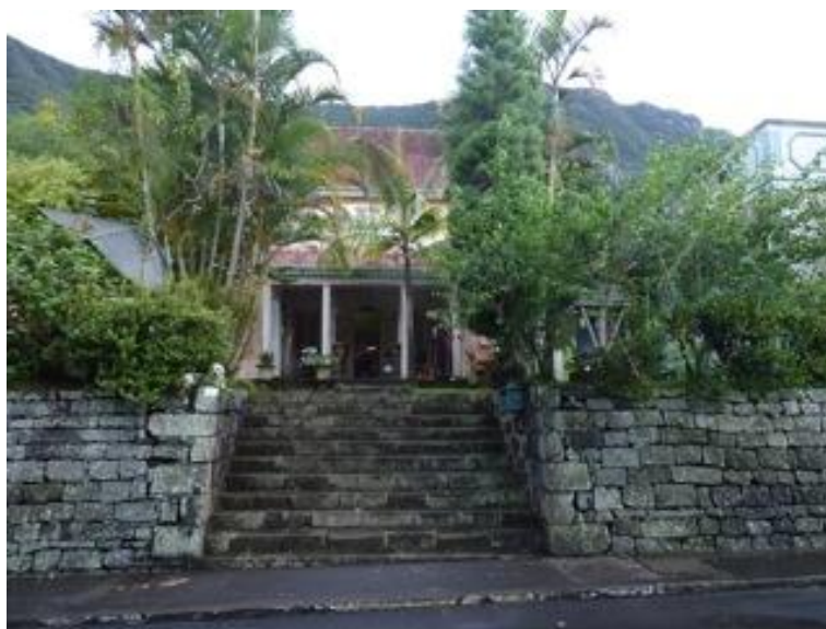
Figure 14 : Exemple d'une clôture en pierres sèches à Salazie, Source : Bénédicte JARLET
