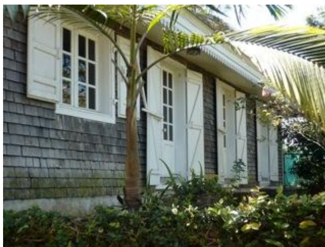
Façade en bardeau d'une case créole
